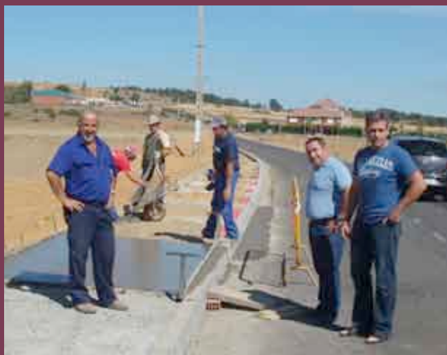
El concejal de Infraestructuras, a la dcha., visitó las obras.
