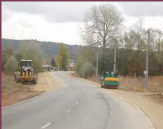
El carril bici se construirá en los márgenes de la carretera.
