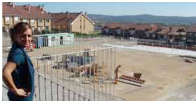
La concejala de Educación y Cultura inspeccionó las obras
