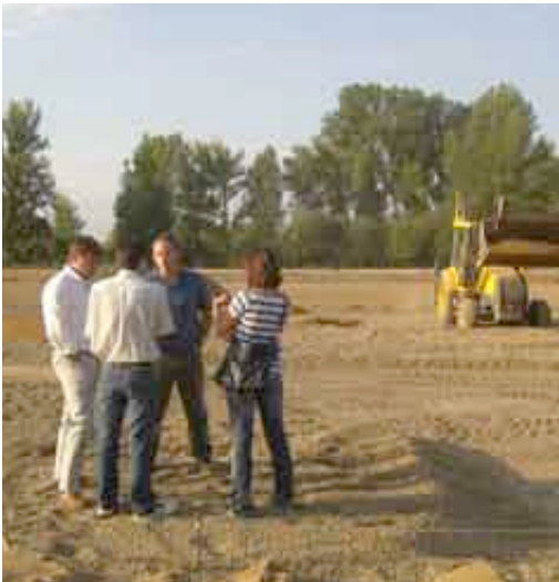
El concejal de Deportes inspeccionó las obras del área deportiva
