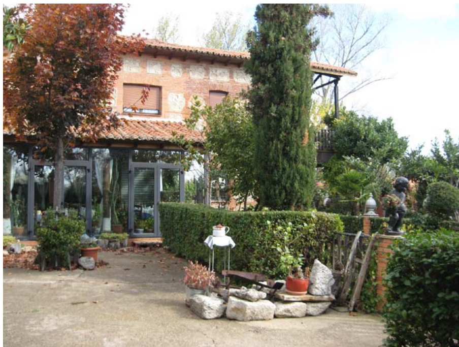
Molino nº 1 o restaurante de Javier Emperador, ubicado a en el área septentrional del SUR-16, en el que se observa su reciente restauración, tanto de la estructura arquitectónica como del interior del mismo.
